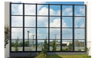
Beispiel: Schallschutzwand- Stahl und Glas
